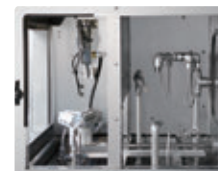
乾燥室 洗浄室
