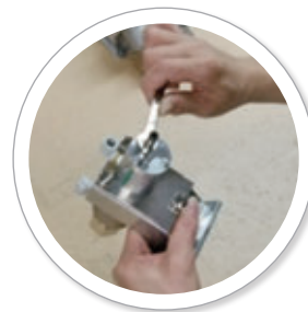
バルブ取付工程
